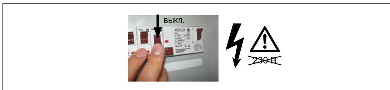
Рис. 5.1 Обесточивание агрегата
